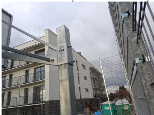
Fot. 1 Kosz do koszykówki – sposób montażu
